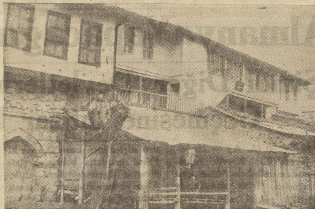
Beypazarında dispanser binası
